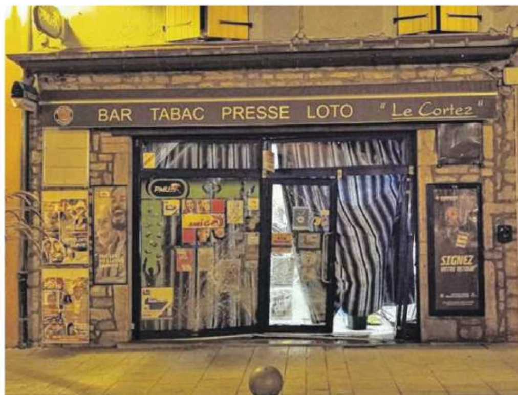
Les dégâts sur la vitrine du commerce sont importants (©Voix du Jura)
