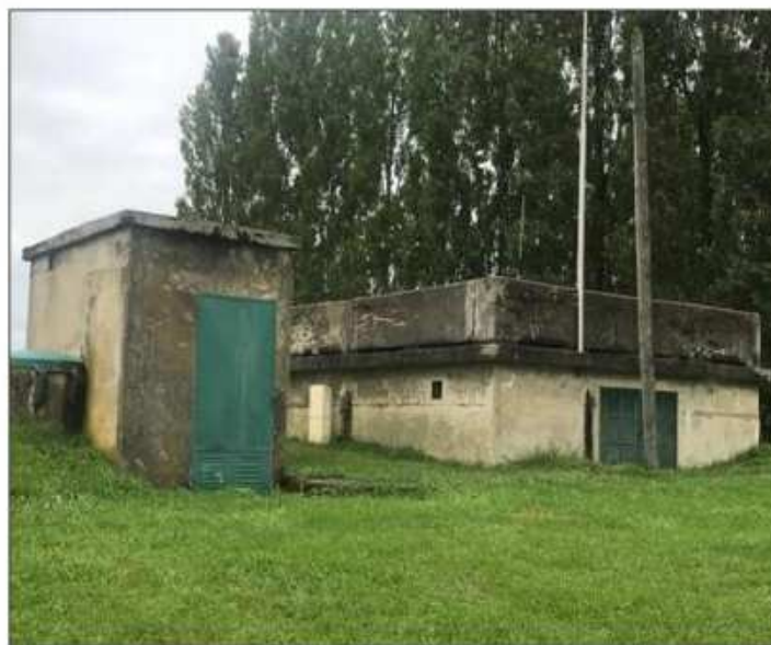
La surchloration momentanée du réseau public s'est traduite par une baisse des taux des deux bactéries présentes depuis quelques jours dans l'eau potable, la rendant impropre à la consommation. Photo DR
