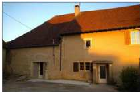
L'habitation, très vétuste, sera réhabilitée. Photo Progre/Benjamin GAFFRE
