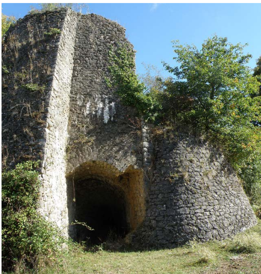
Four à chaux : la Bazouge-de-Chénéré (Mayenne)
