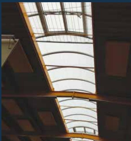
Malgré un aspect simple voire banal, il recèle de technologies qui permettent d'actionner de façon automatique toute une série d'ouvrants afin d'évacuer les fumées le cas échéant.
